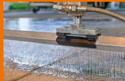
Druckloser Auftrag des Reaktionsharzes
