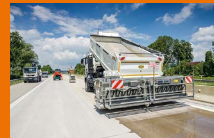
Abstreuung mittels Walzenstreuer
