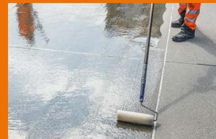
Herstellen des definierten Randabschlusses
